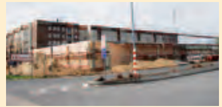
Hier entsteht ein Getränkemarkt. Die Wärmeversorgung übernimmt die SBL.
